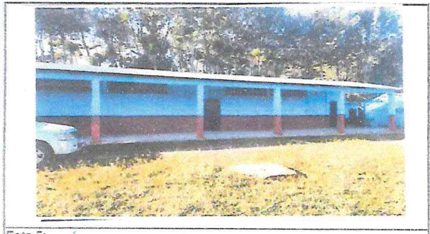
Foto 5: pintura en todo el edificio
